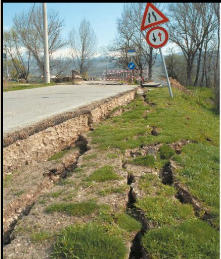
Smottamenti del terreno lungo una strada dopo il terremoto in Abruzzo del 2009.
